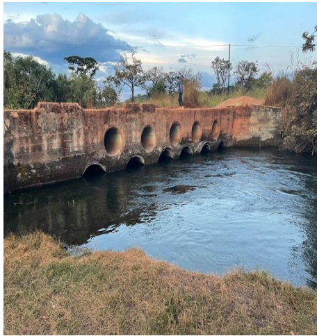
Kifubwa River culverts
