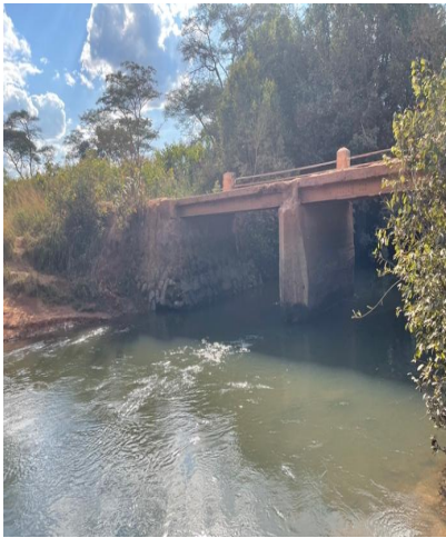
Kafue River Bridge
